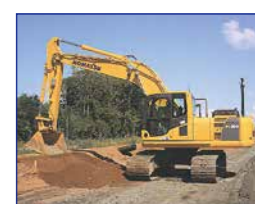
自動制御で施工
